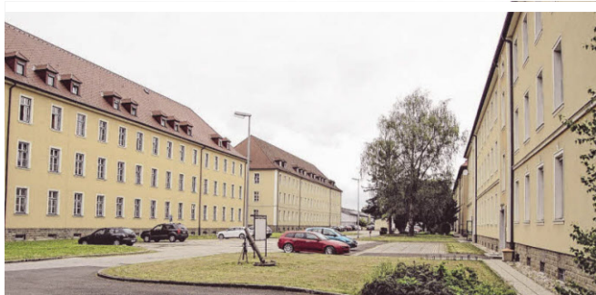
Elf frühere Mannschaftsgebäude stehen jedoch unter Denkmalschutz
